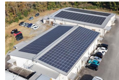
太陽光パネル
